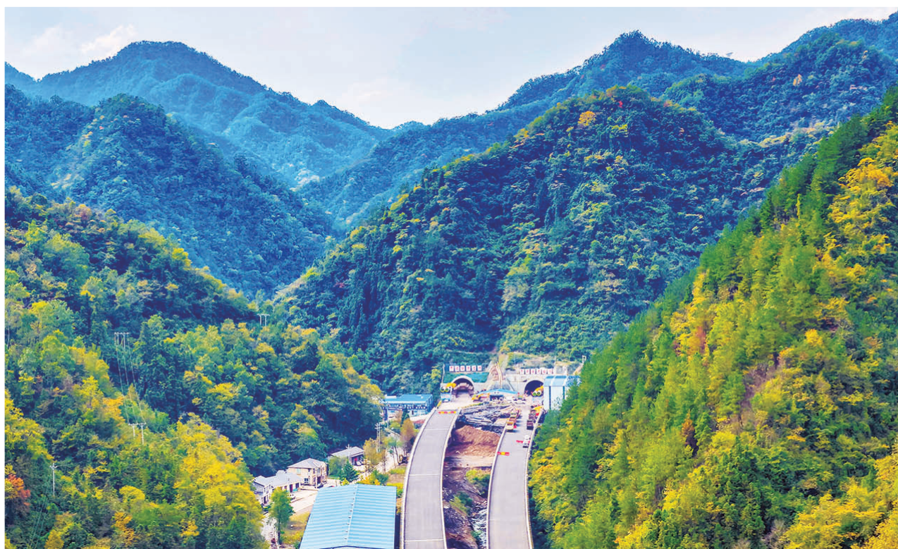
十巫南高速公路7标段控制性工程——界梁隧道进口端开始洞身掘进。
