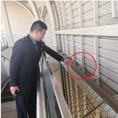
手机从护栏旁的夹缝中掉到横梁上。
