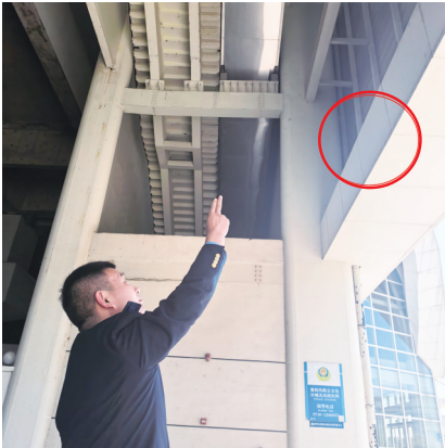
手机掉落在距离地面20米高的横梁上。
