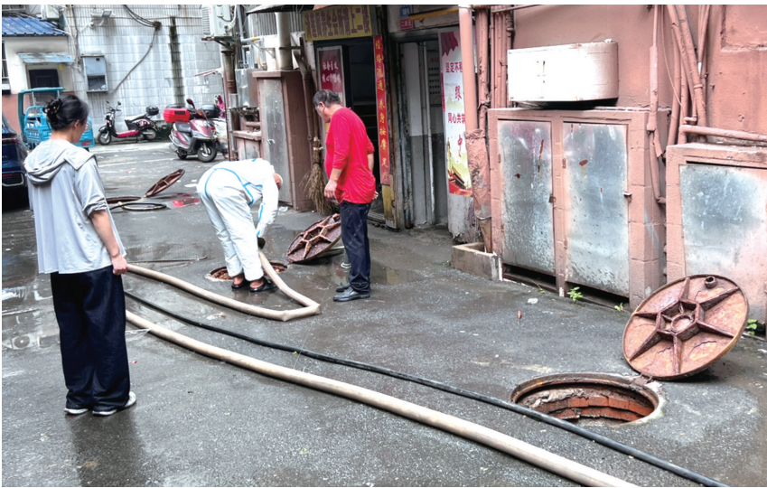
工作人员开展管网清掏疏通。
