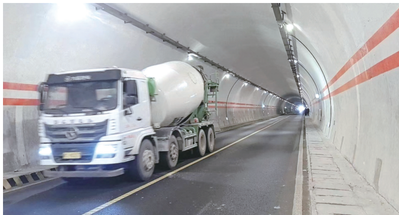
智慧照明系统已在我市多个隧道投用。
