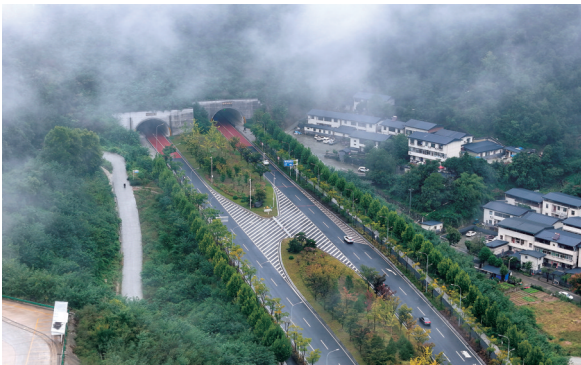
三峡路隧：大道出山，穿行青绿之间。
