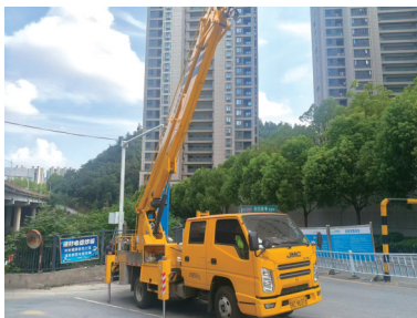
施工人员安装违停抓拍设施。
