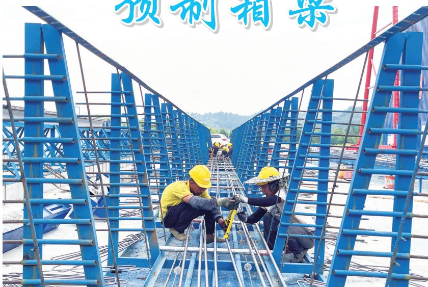
施工人员绑扎钢筋,为预制箱梁做准备。图/记者 徐国文
