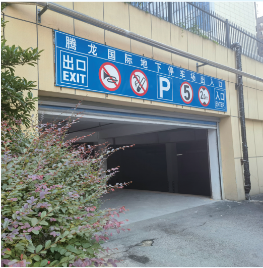
腾龙国际小区地下停车场。
