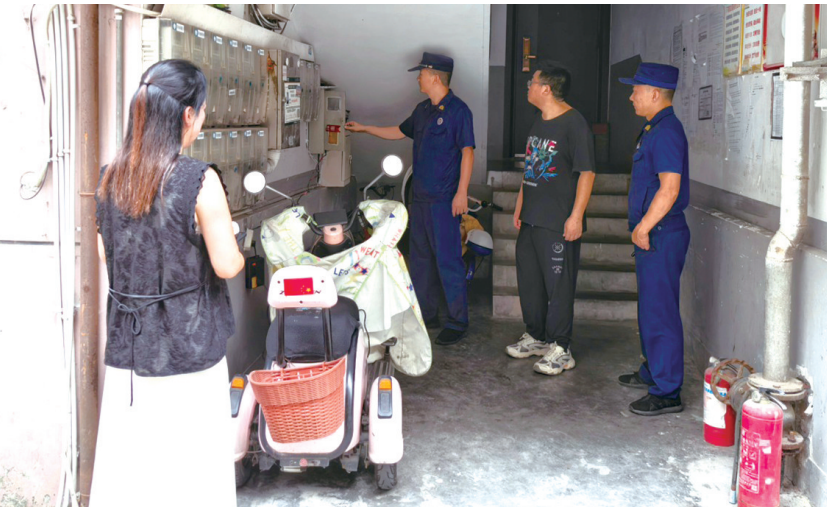
工作人员在一楼栋检查消防设施。
