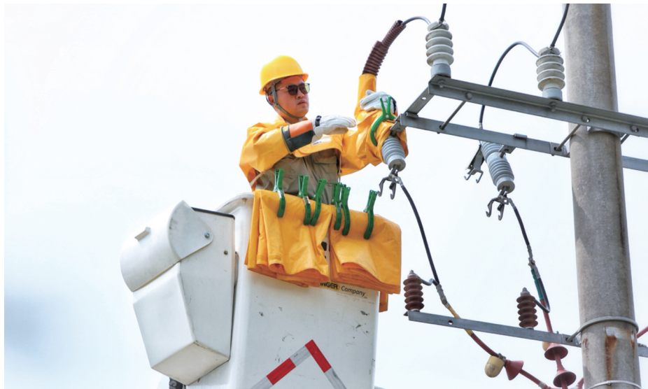
柯有良站在斗臂车上进行高空带电作业。
