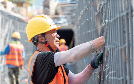
7月22日,茅箭区文昌路地下管廊施工现场,工人头顶烈日绑扎钢筋。 记者 刘昆 摄
