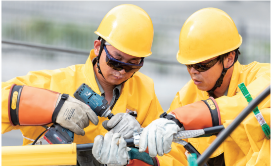
7月16日,电力工人身着厚重严实的绝缘防护服、佩戴绝缘防护手套,开展高空带电作业。 记者 刘昆 摄
