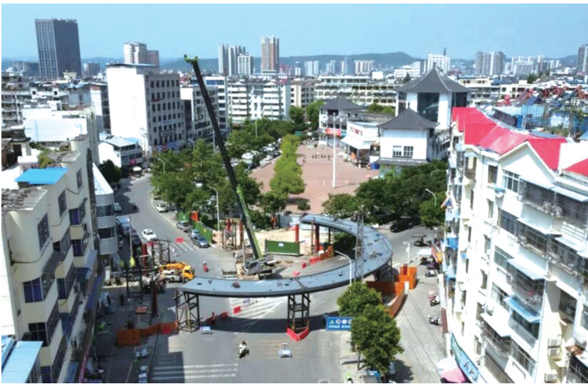
大丹天桥正加紧施工。
