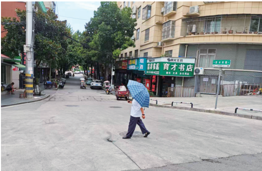
未整改前,路口斑马线磨损模糊,行人从此通过存在安全隐患。
