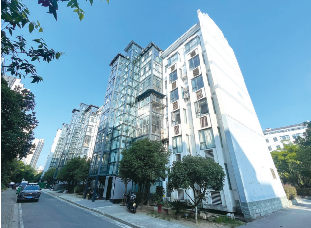
桐华苑小区新加装的电梯。
