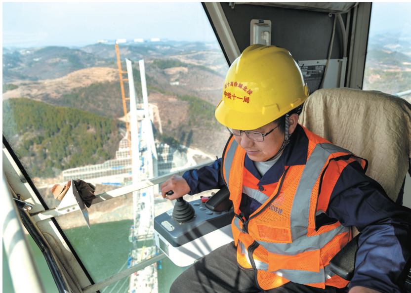
潘恒勇驾驶塔吊在西十高铁汉江特大桥上工作。(资料图片) 图/记者 刘昆
