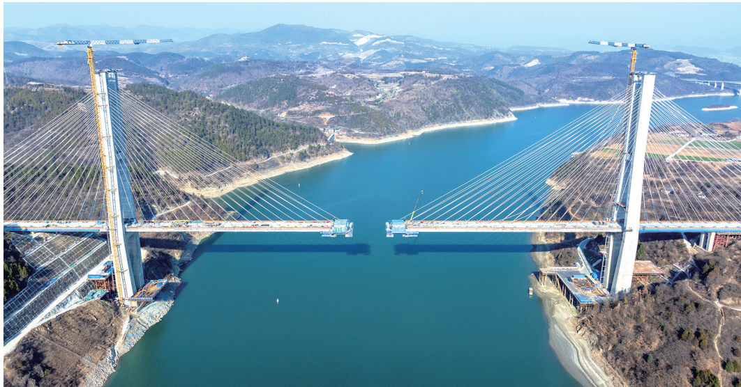
西十高铁汉江特大桥施工现场。(资料图片)
