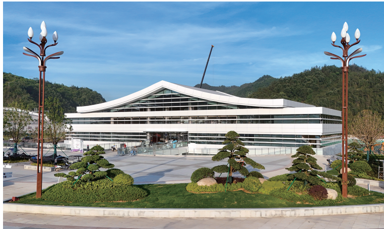
新建成的西十高铁郧西站。
