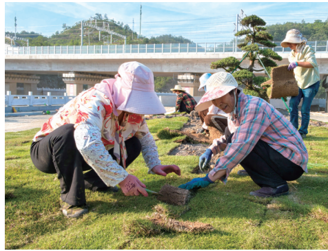
施工人员铺设草皮。
