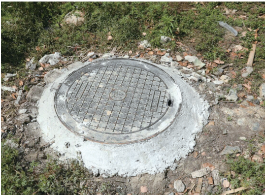
加固破损窞井盖,消除安全隐患。
