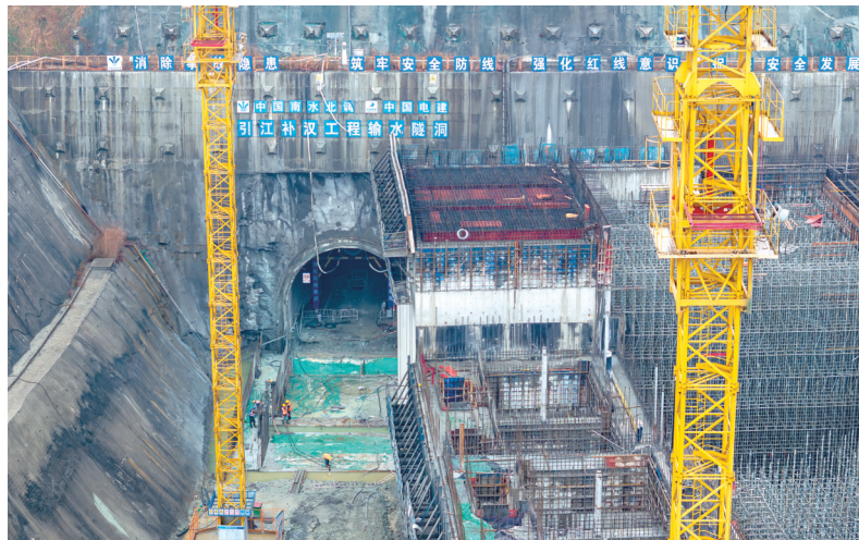
1月30日上午,引江补汉工程输水总干线出口段工程正式贯通。
