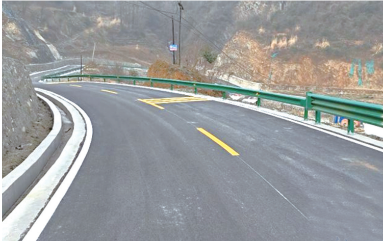
已开通的朝北沟旅游公路。
