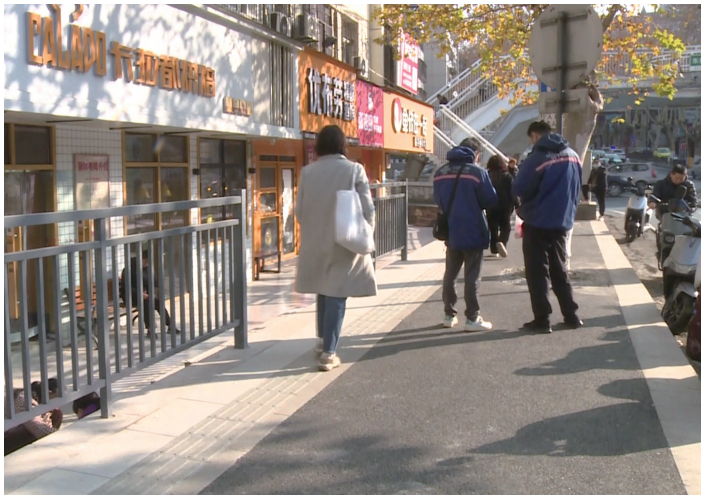
改造后的人行道路面平整。
