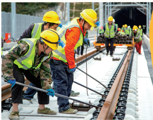
铁路工人相互配合将钢轨下的滑轮取出。
