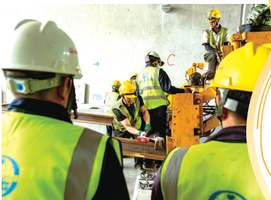
西十高铁铺轨进入秦楚隧道。
