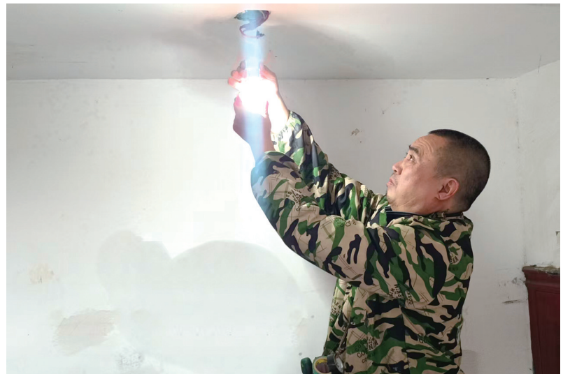
王峰更换照明灯。
