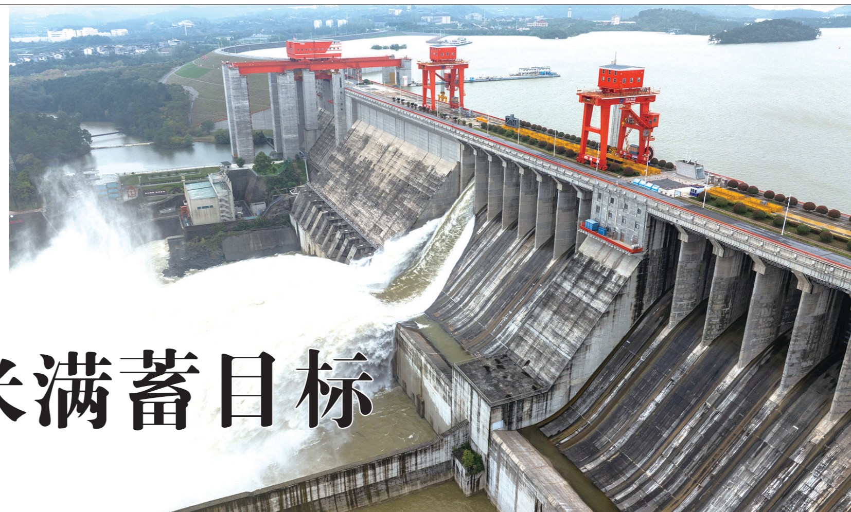
10月18日,丹江口大坝开启3孔持续泄洪。
