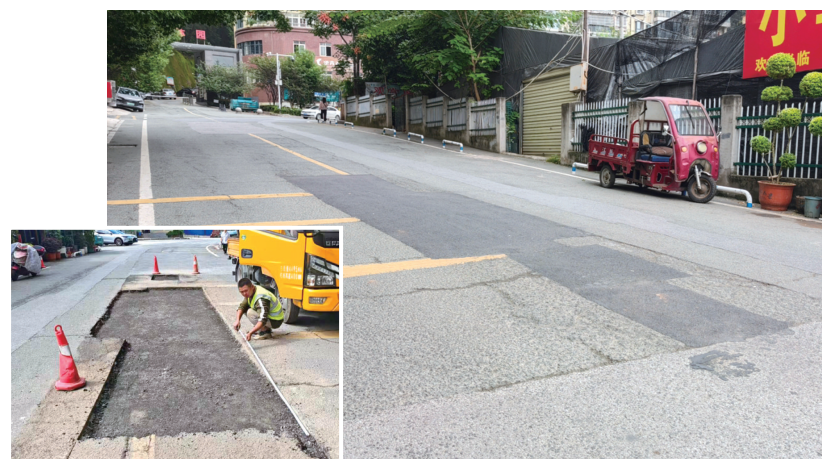
施工人员正在划线定位。
