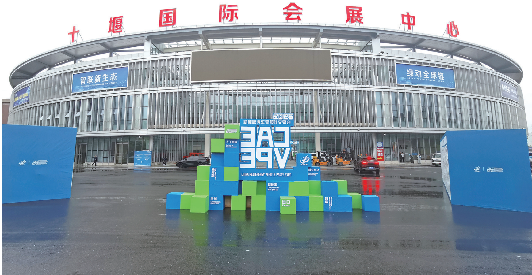
十堰国际会展中心已完成布展工作。图/记者 张启国
