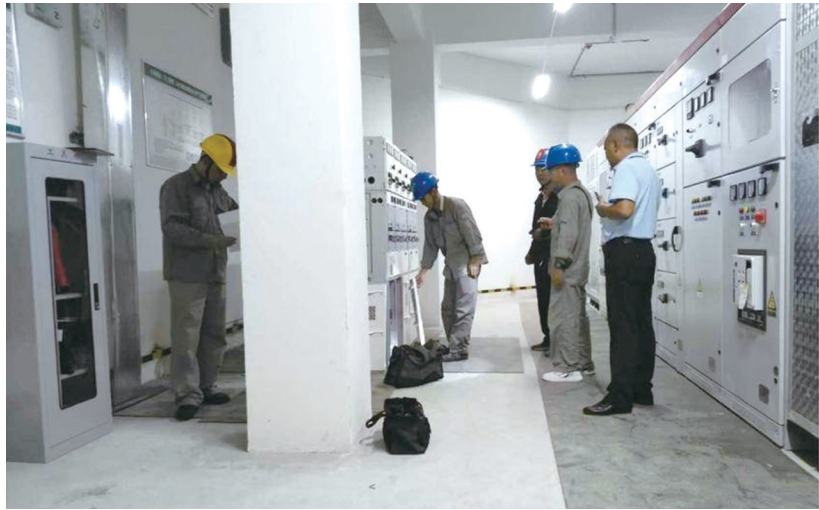
施工人员现场进行用电改造。
