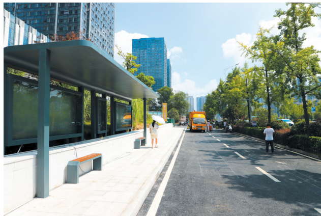
万达港湾式公交站主体建设已完工。
