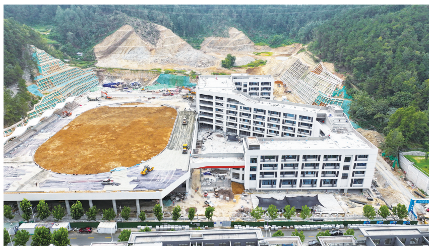
火箭路学校正在进行收尾工程。
