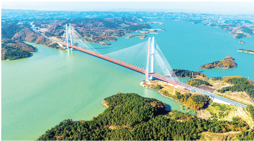
丹江口水库特大桥是世界最大跨径的地锚式斜拉桥。
