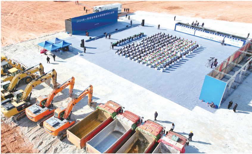
2024年一季度全市重大项目集中开工活动现场。
