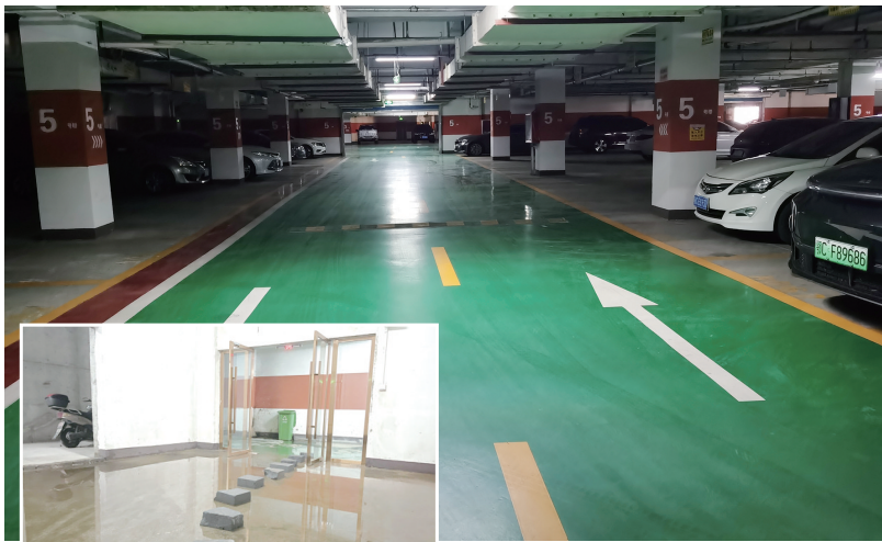
经过维修,地下车库积水问题解决了。
