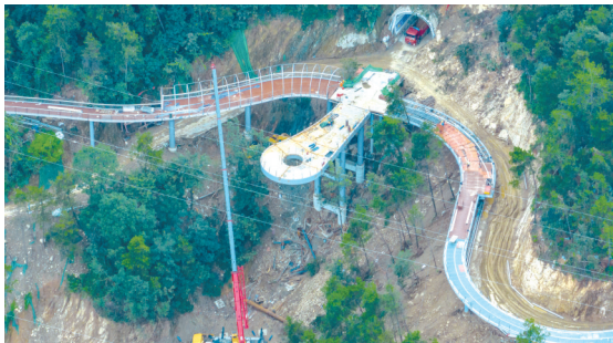
护栏安装等工程正加快推进。
