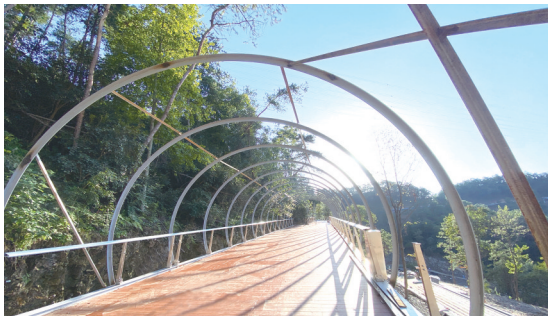
健康步道的竹木地板基本铺设完成。
