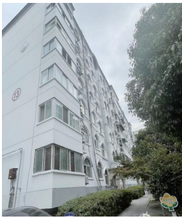
改造后,整个楼栋焕然一新。
