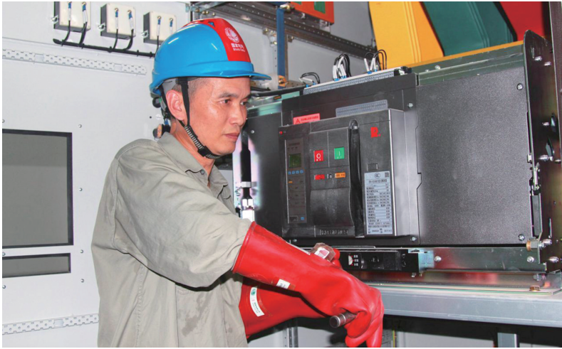
王斌在昊朔公司配电工程项目建设现场。
