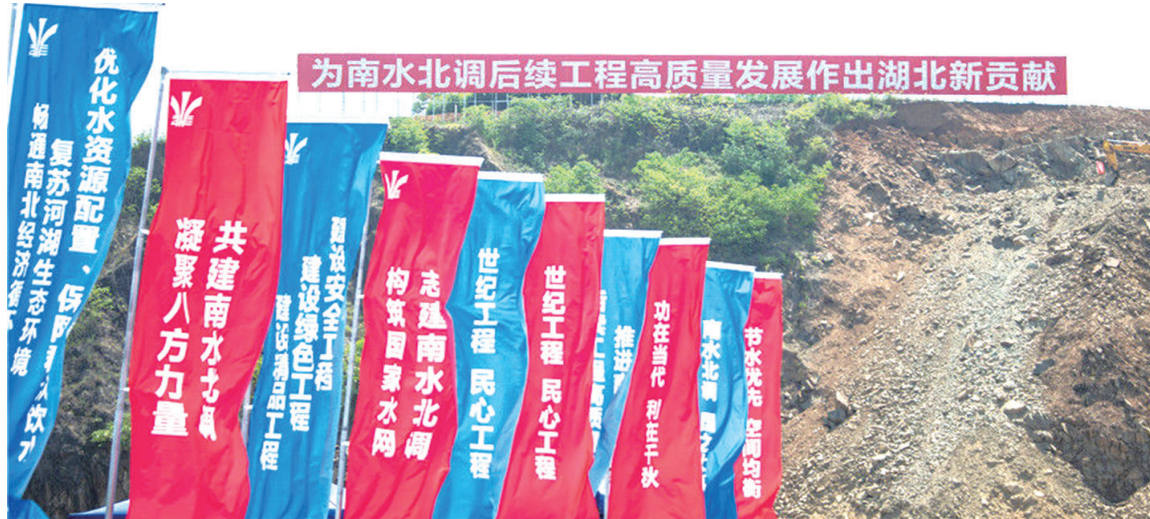
7月7日引江补汉工程开工现场,“为南水北调后续工程高质量发展作出湖北新贡献”的横幅格外醒目。据新华社
