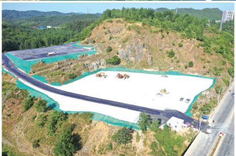
引江补汉工程开工动员大会分会场41亩场地已完成平整工作。
