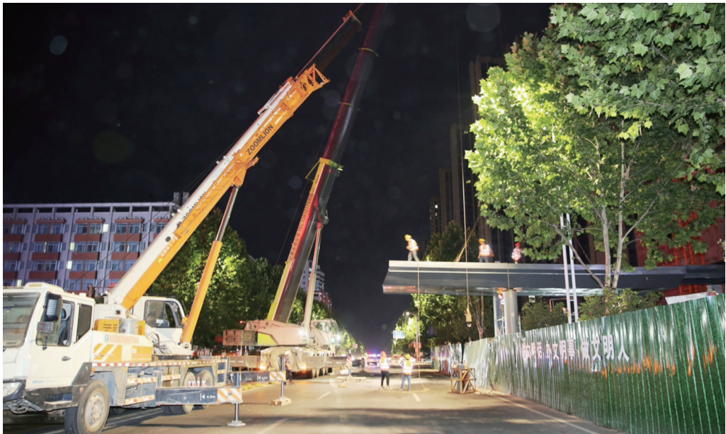
工作人员连夜施工,天桥主箱梁顺利完成吊装。
