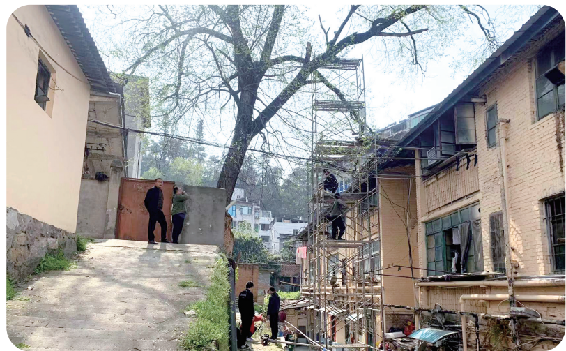
记者来到安装三处小区时,施工队正在钢架上锯树枝。
