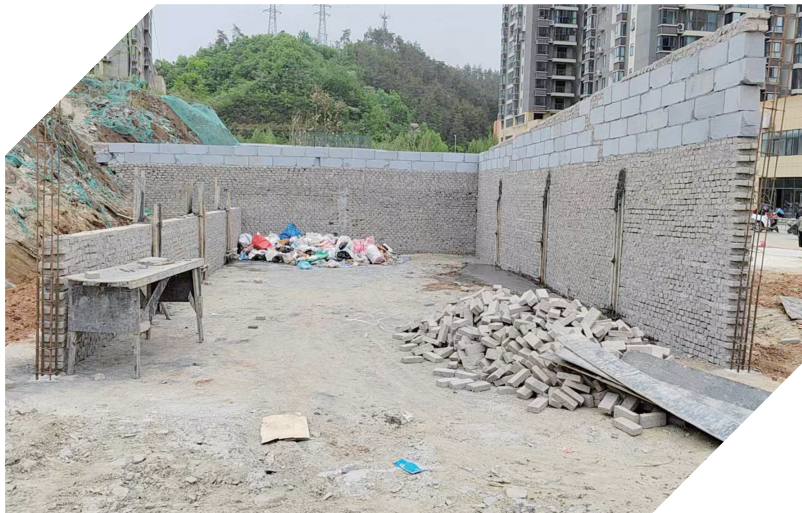
目前,开发企业已对这个垃圾堆放点停止施工。
