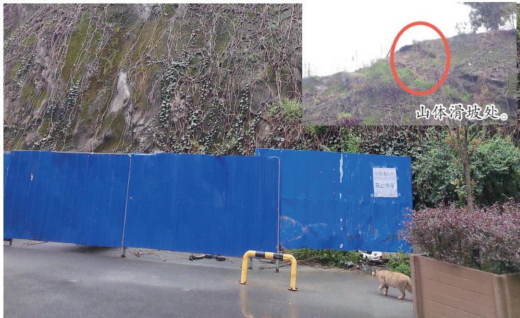
围挡正好位于消防通道的拐弯处。
