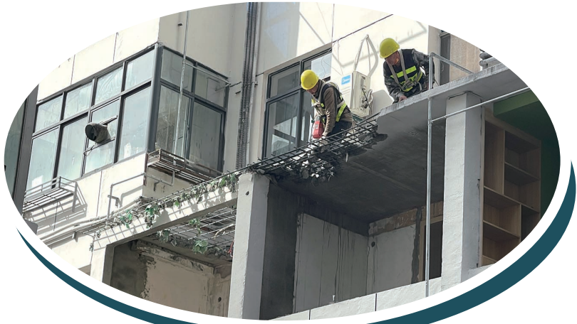
工作人员正在对一楼两间违建房屋的屋顶进行拆除。
