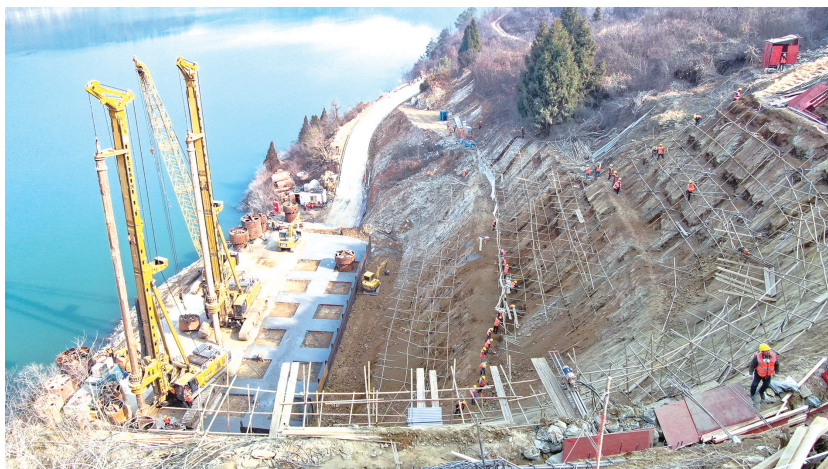
汉江特大桥施工现场,建设者正紧张施工。
