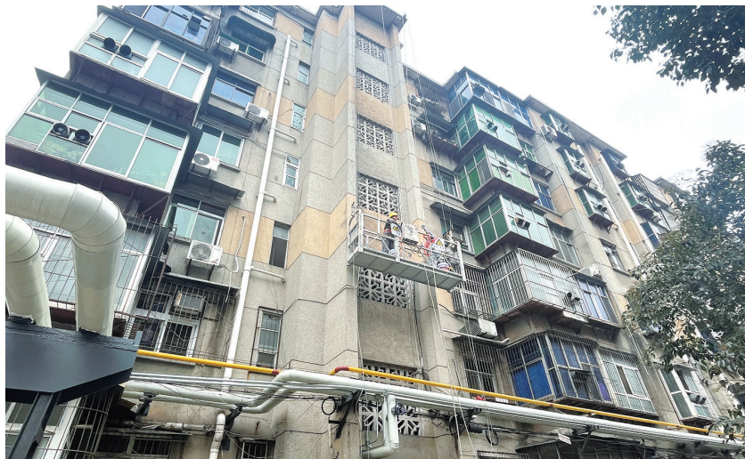
施工人员在飞达南村小区粉刷楼栋外墙。
