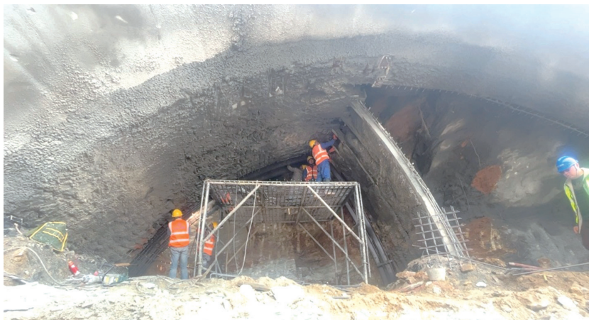
八亩地隧道施工现场,建设者加紧掘进隧道。
