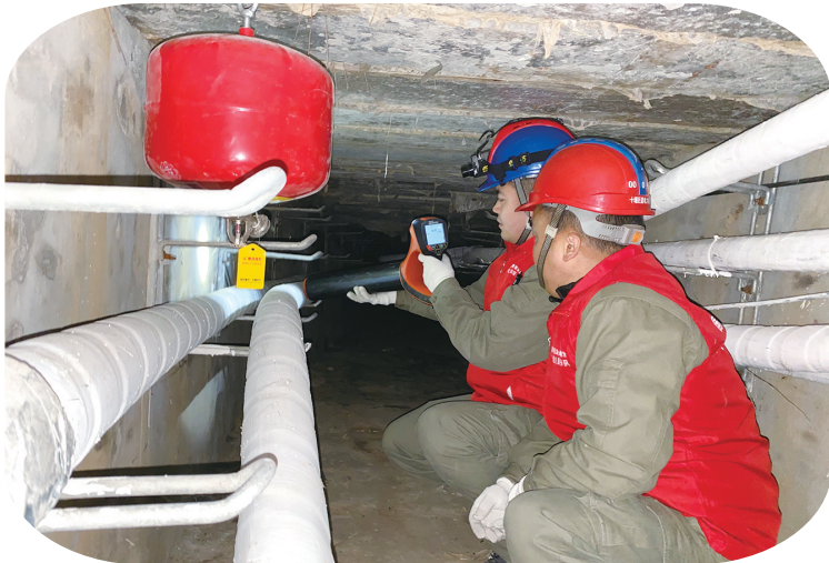
巨能配电工程公司深入查找电缆隐患,为电缆消缺“精准定位”。
