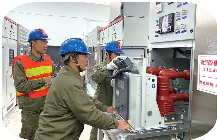
巨能配电工程公司服务宇浩高科配电工程项目建设。
