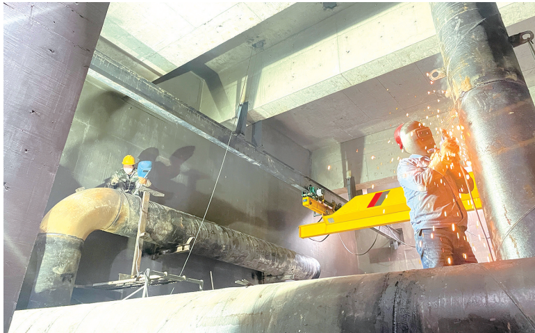
新建的污水管道旁,电焊工对管道接口进行焊接。
