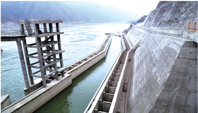
孤山航电枢纽正在建设中的鱼道。
