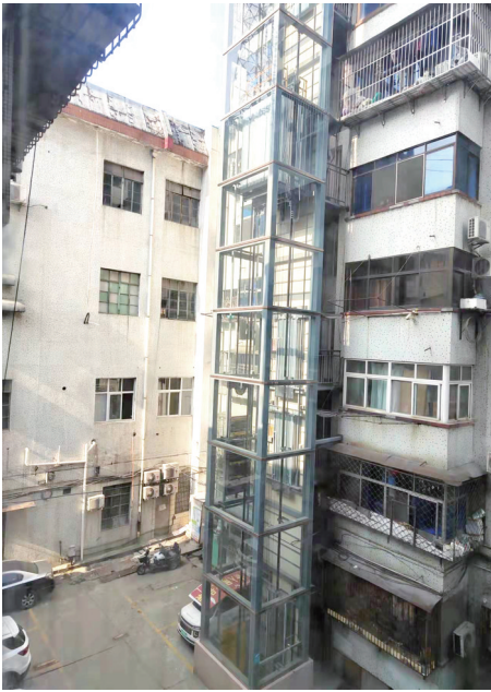
小区加装电梯始终未验收。
