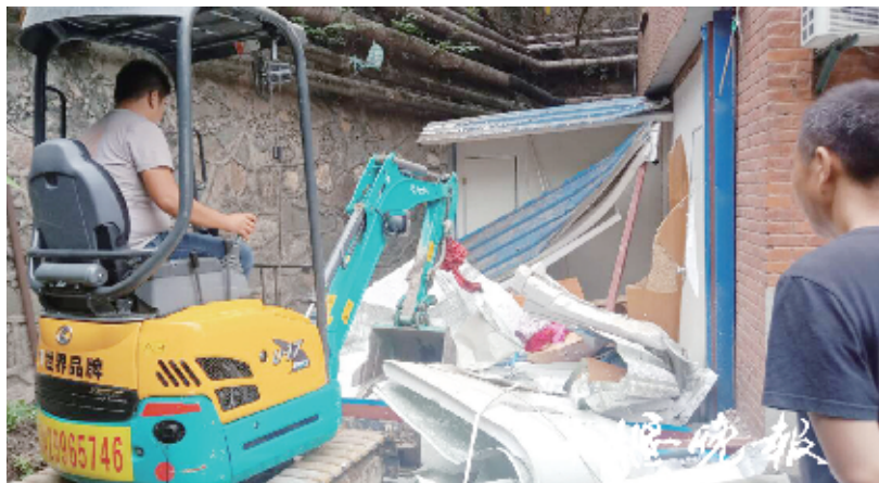
社区对违建进行拆除。
